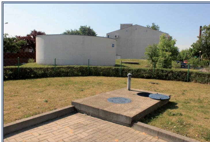
Rys. 1. Ujęcie wody Szpitala Powiatowego Sp. z o.o. w Jarocinie
