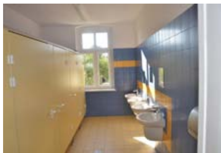
Rys. 9. Pomieszczenie sanitarne Akademii Talentów Prywatnej Szkoły Podstawowej w Wągrowcu
