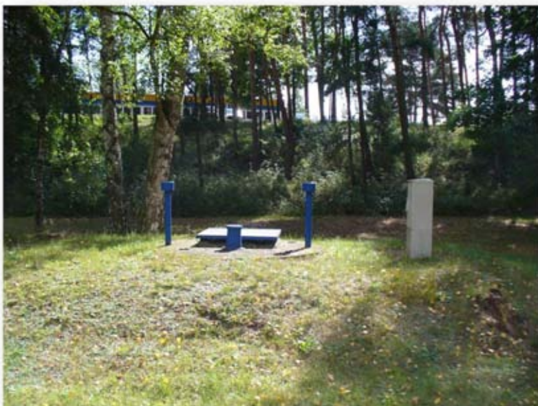
Rys. 1. Ujęcie wody - Wodociąg publiczny Oborniki
