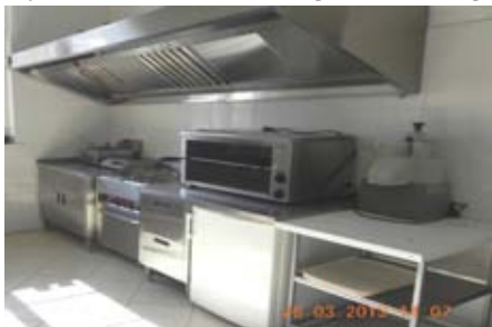
Rys. 12. Pomieszczenie lokalu gastronomicznego
