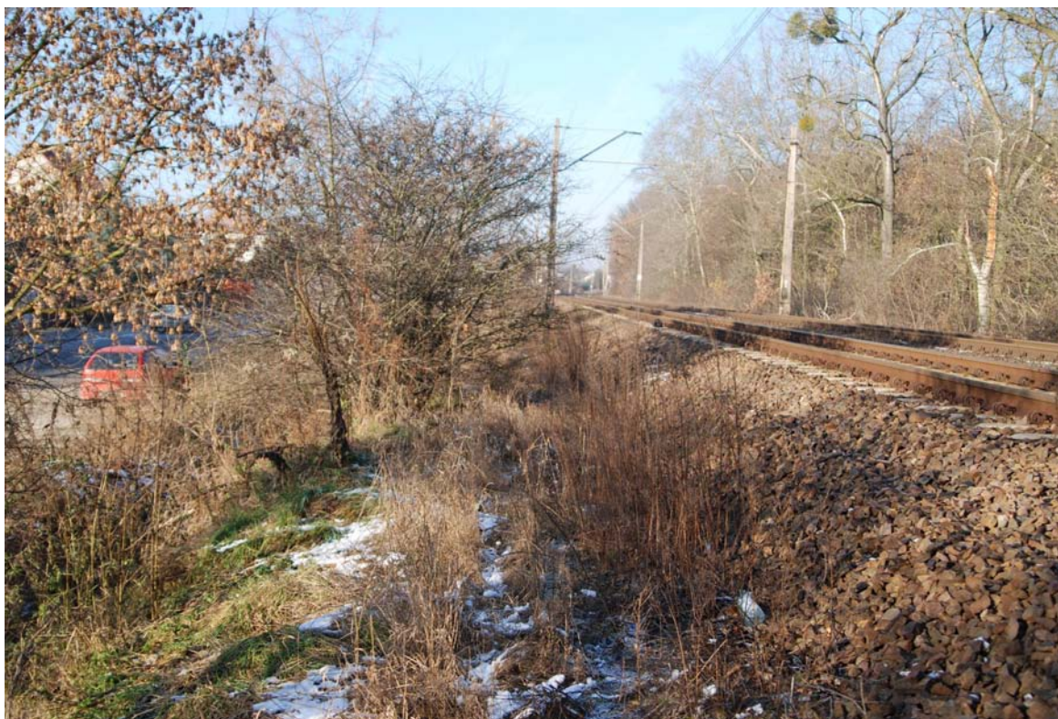
Fot. 2. Pas zieleni oddzielający torowisko od ulicy Żarnowieckiej
