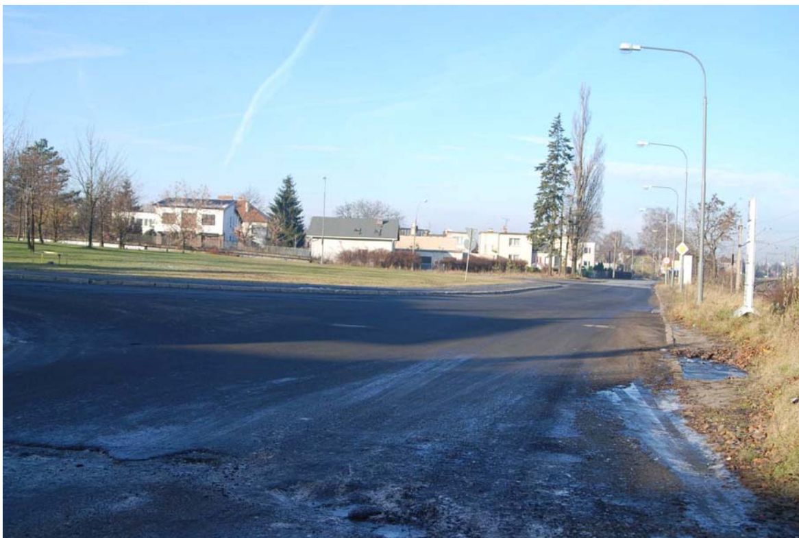
Fot. 4. Miejsce przyłączenia do bocznicy WZM. Konieczność budowy muru oporowego.
