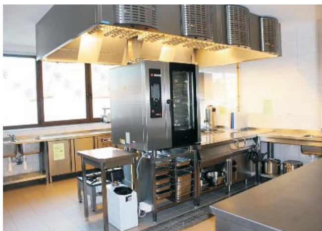
Rys. 12. Pomieszczenia kuchenne stołówki przedszkola ze żłobkiem
