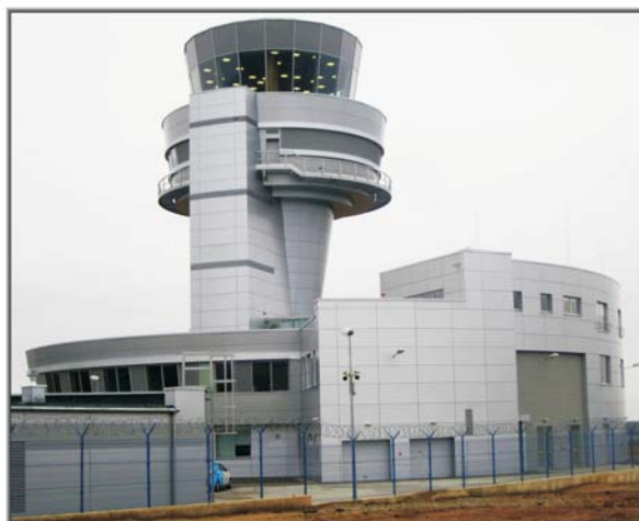
Rys. 6. Wieża kontroli lotów - Port Lotniczy Poznań-Ławica
