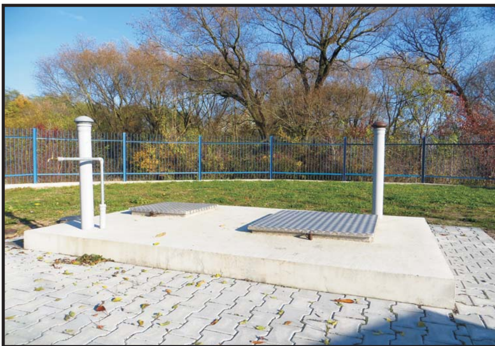
Rys. 1. Ujęcie wody wodociągu publicznego Konin-Kurów (powiat koniński)
