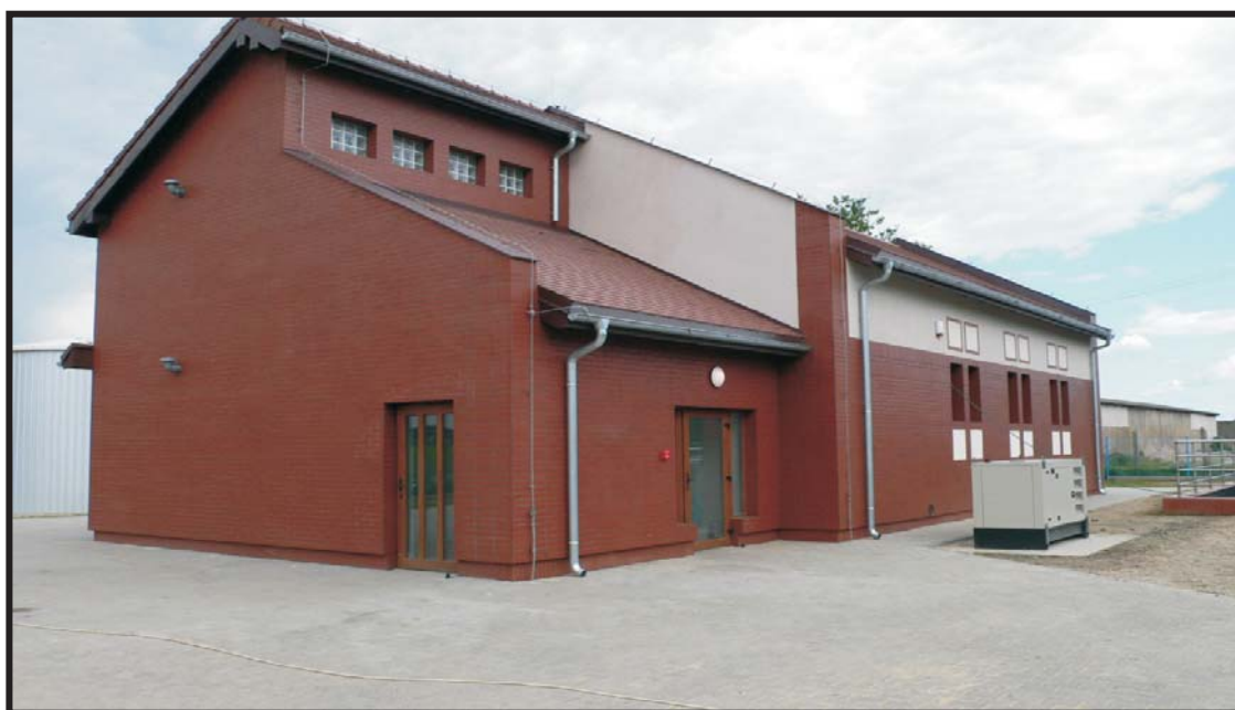
Rys. 10. Wodociąg publiczny w Podaninie - budynek Stacji Uzdatniania Wody po kapitalnym remoncie (powiat chodzieski)
