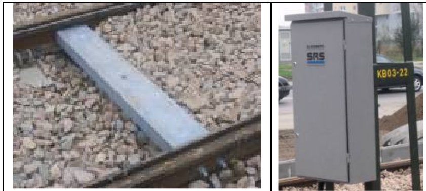
Rysunek nr 17. Przykład smarownicy torowej SRS oraz szafy z aparaturą sterowniczą smarownicy ( http://www.transportszynowy.pl )
