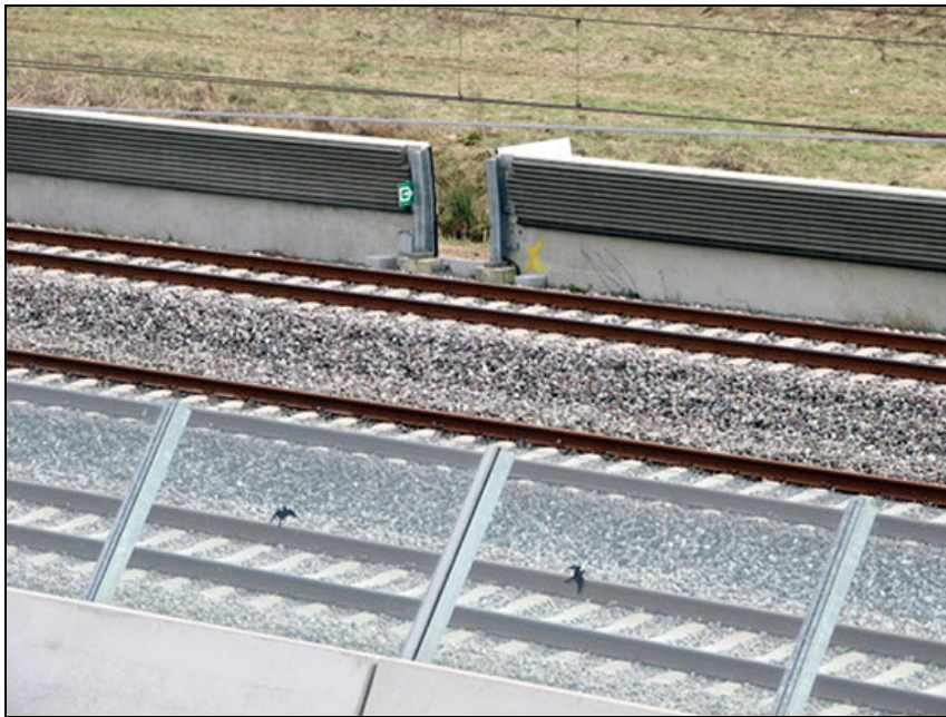
Rysunek nr 16. Widok niskiego ekranu akustycznego przy torowisku kolejowym (Holandia)
