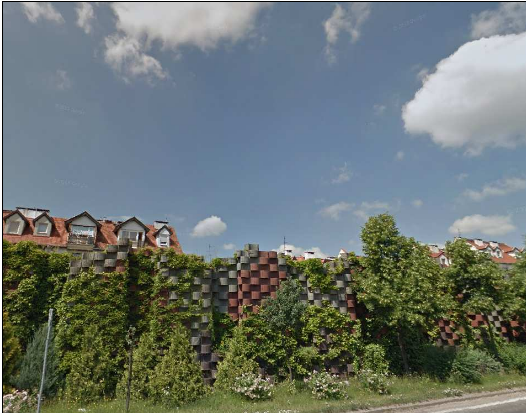
Rysunek nr 10. Widok ekranu akustycznego chroniącego zabudowę mieszkaniową osiedla Ogrody w Lesznie
