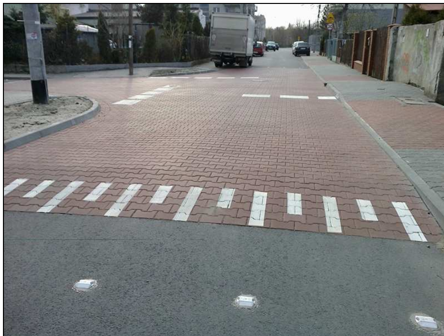
Rysunek nr 11. Przykład wyniesionego skrzyżowania (Źródło: zm.org.pl)
