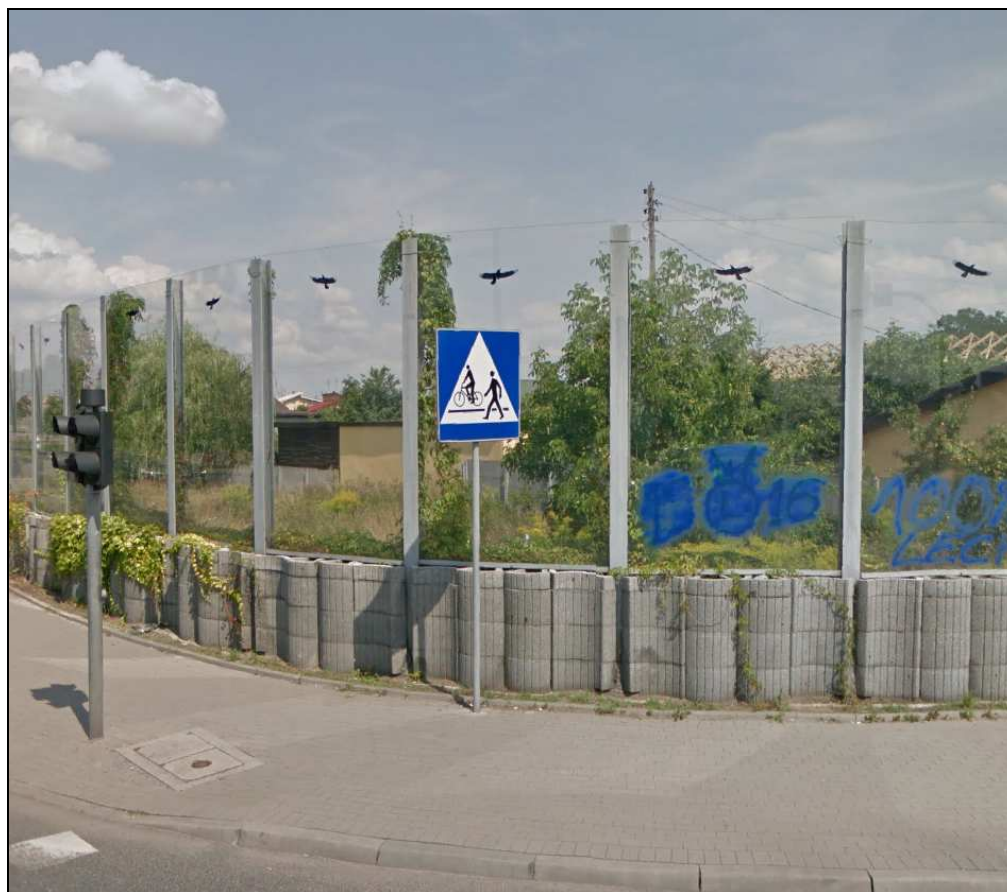
Rysunek nr 13. Widok ekranu akustycznego w rejonie skrzyżowania Trasy Bursztynowej z ul. Zagórowską w Koninie
