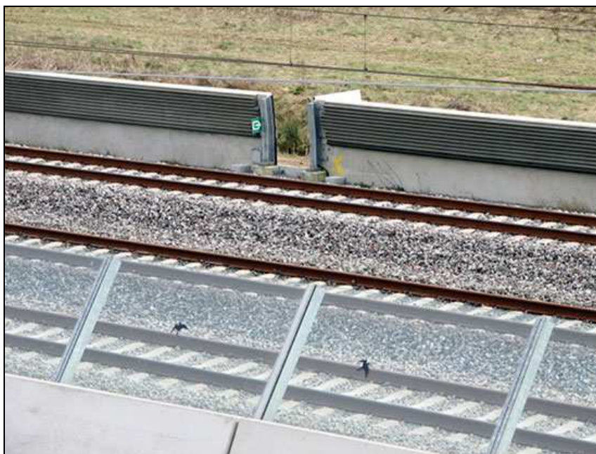
Rysunek nr 16. Widok niskiego ekranu akustycznego przy torowisku kolejowym (Holandia)
