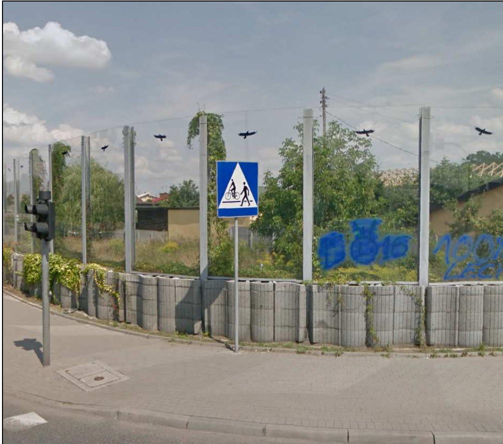
Rysunek nr 13. Widok ekranu akustycznego w rejonie skrzyżowania Trasy Bursztynowej z ul. Zagórowską w Koninie
