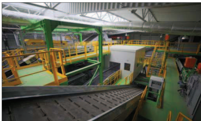
Fot. Hala sortowni na terenie ZZO Olszowa Sp. z o. o.
