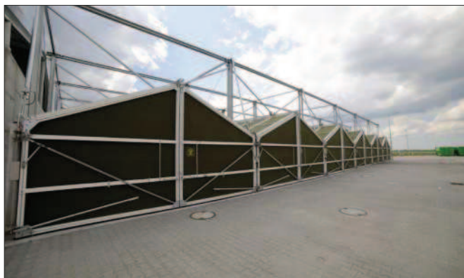
Fot. Reaktory stabilizacji tlenowej na terenie ZZO Olszowa Sp. z o.o.
