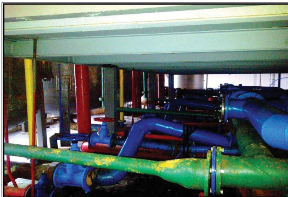
Rys. 10. Wyeksploatowane urządzenia wodociągowe przed modernizacją
