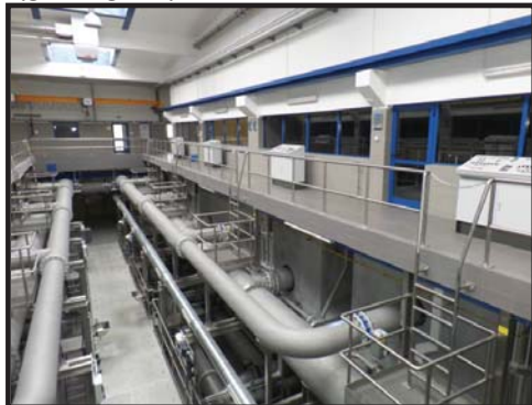
Rys. 8. Stacja Uzdatniania Wody w Mosinie – filtry węglowe z galerią rur
