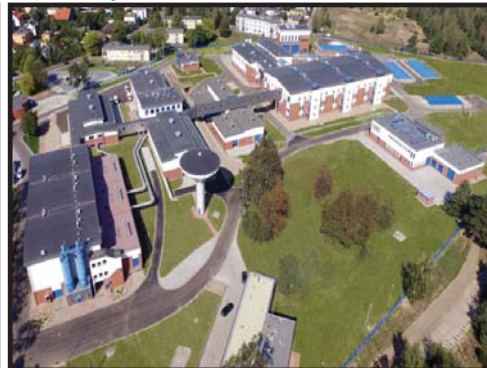
Rys. 9. Stacja Uzdatniania Wody w Mosinie po modernizacji
