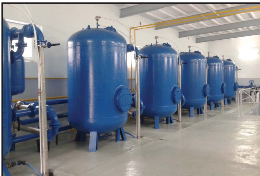
Rys. 13. Wodociąg publiczny Sokołowo (powiat wrzesiński) – Stacja Uzdatniania Wody
