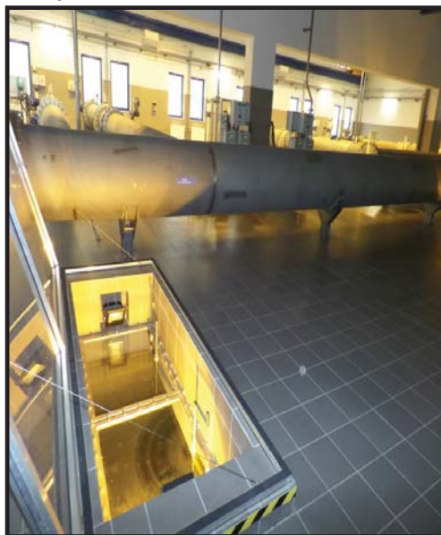
Rys. 7. Stacja Uzdatniania Wody w Mosinie – komory reakcji w ozonowni
