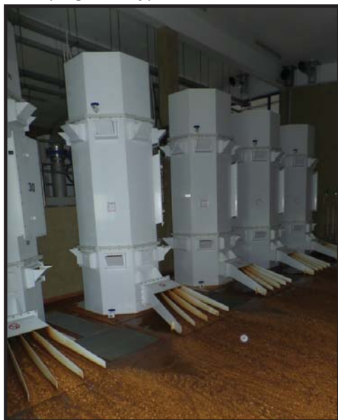
Rys. 6. Stacja Uzdatniania Wody w Mosinie kaskady napowietrzające
