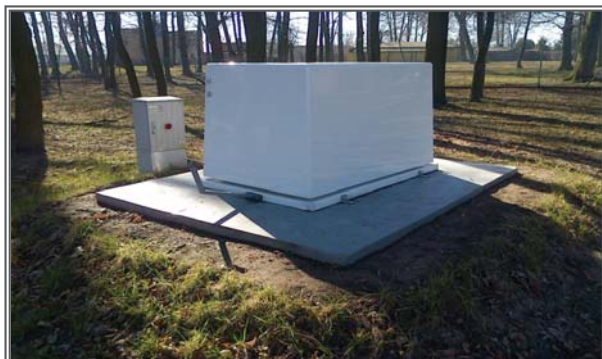
Rys. 1. Ujęcie wody - Wodociąg publiczny Szamotuły
