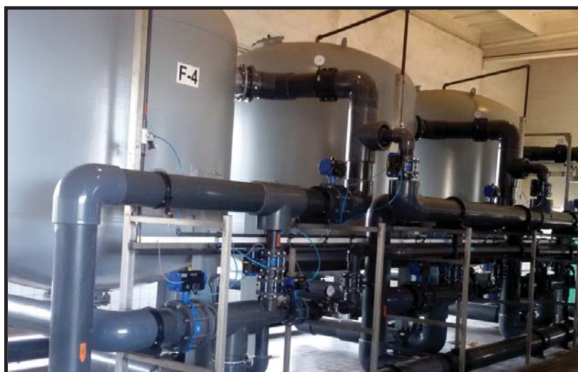
Rys. 12. Wodociąg miejski Pobiedziska (powiat poznański) – Stacja Uzdatniania Wody po modernizacji
