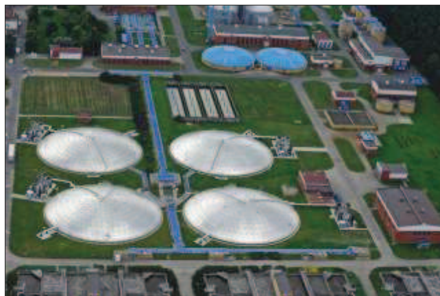
Fot. Centralna Oczyszczalnia Ścieków w Koziegłowach
