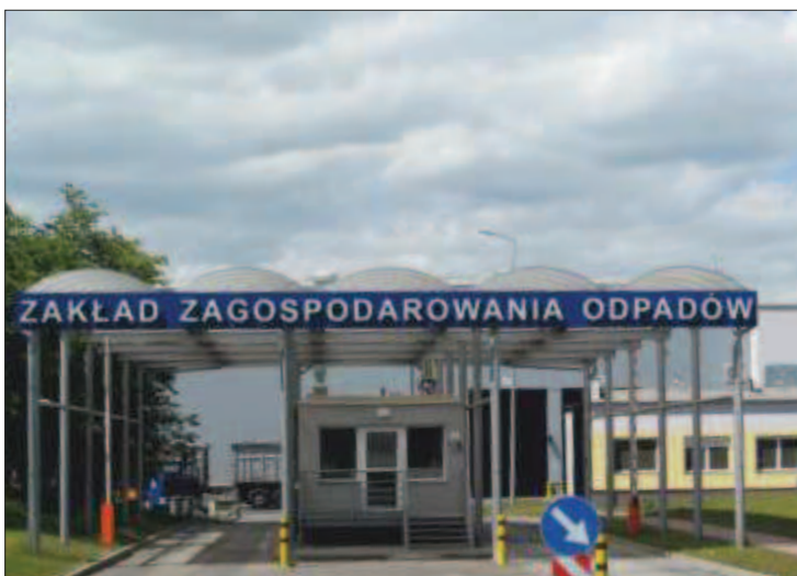
Fot. Zakład Zagospodarowania Odpadów w Lulkowie - Urbis Sp. z o.o. w Gnieźnie
