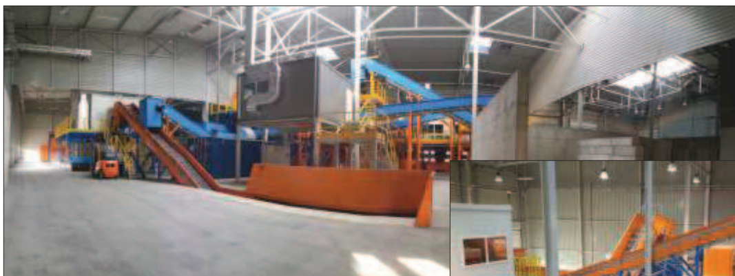
Fot. Hala sortowni - ZZO Nowe-Toniszewo-Kopaszyn
