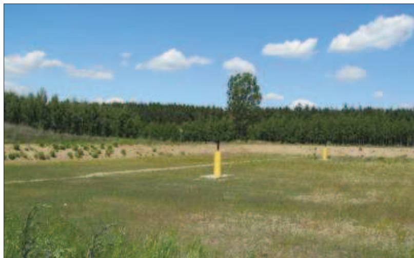
Fot. Nowa kwatera nr II z kominkami odgazowującymi w ZZO w Lulkowie - Urbis Sp. z o.o. w Gnieźnie
