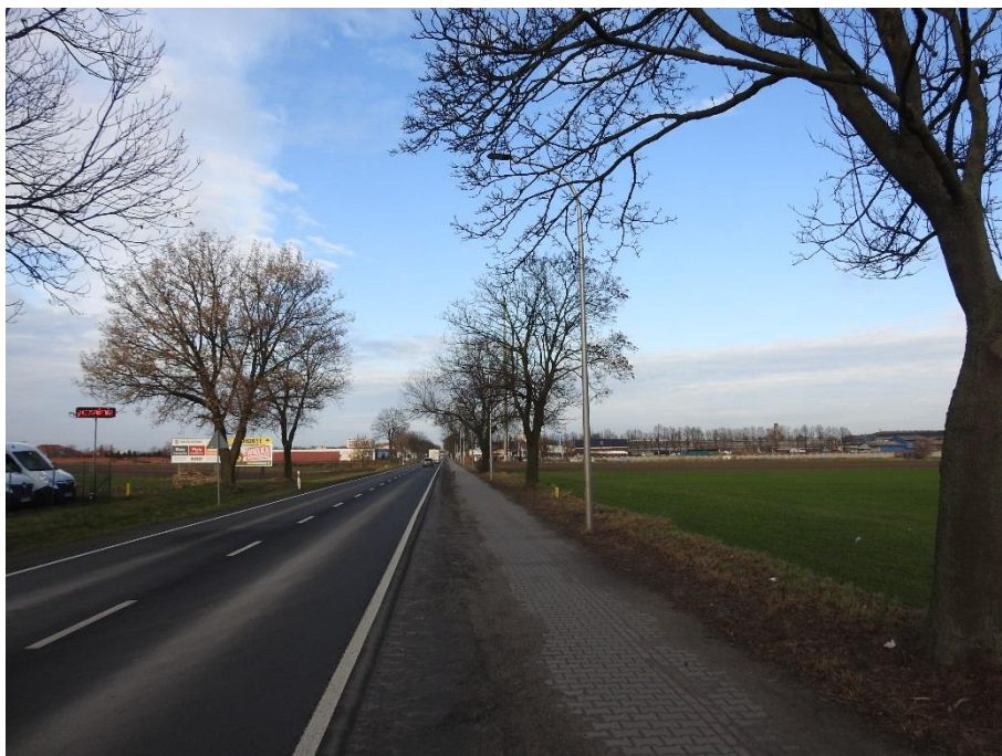
Fot. 16. Droga nr 308 w Kurzej Górze (ul. Gostyńska)
