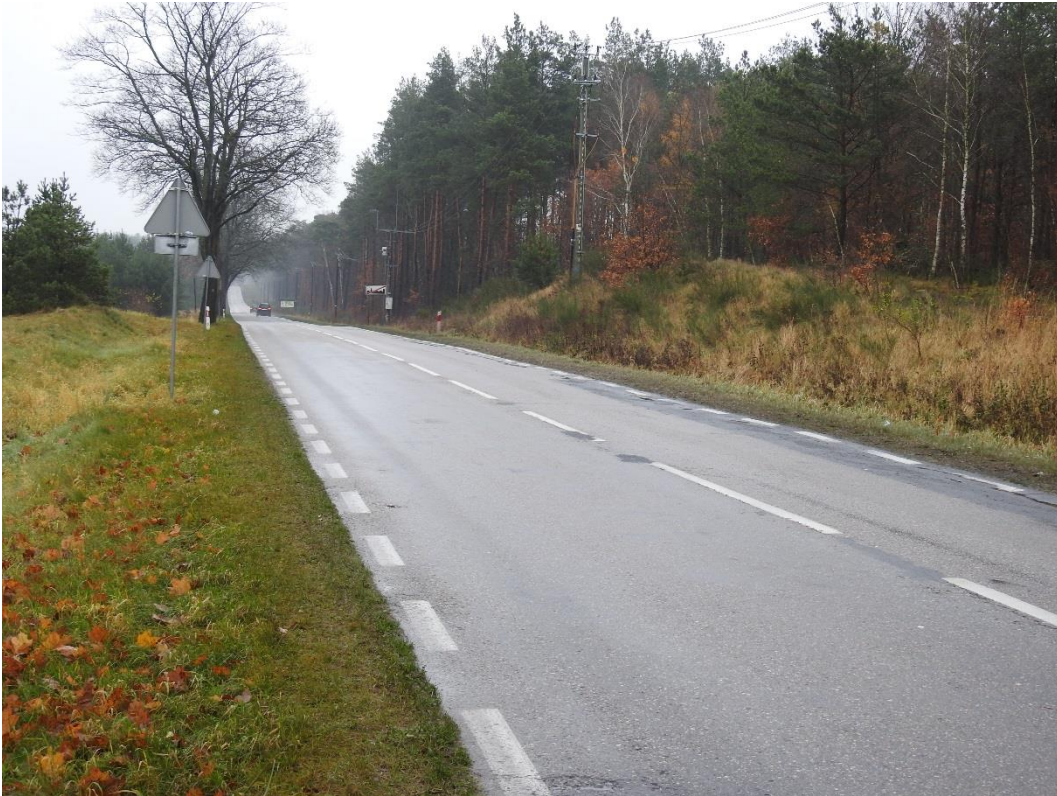
Fot. 1. Droga nr 177 w północnej części Wielenia (ul. Jana Pawła II)
