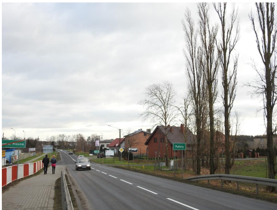
Fot. 33. Droga nr 449 w miejscowości Palaty
