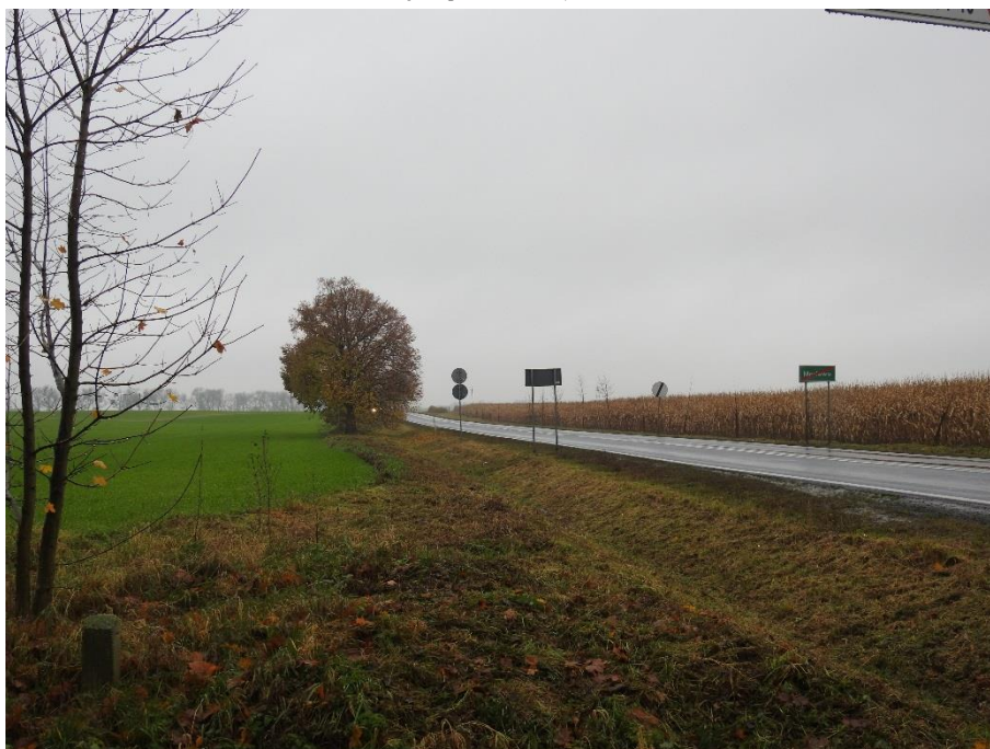
Fot. 8. Droga nr 241 w pobliżu miejscowości Marlewo
