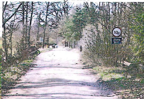
Most na Flincie – jedyny wyjazd w stronę drogi DK11
