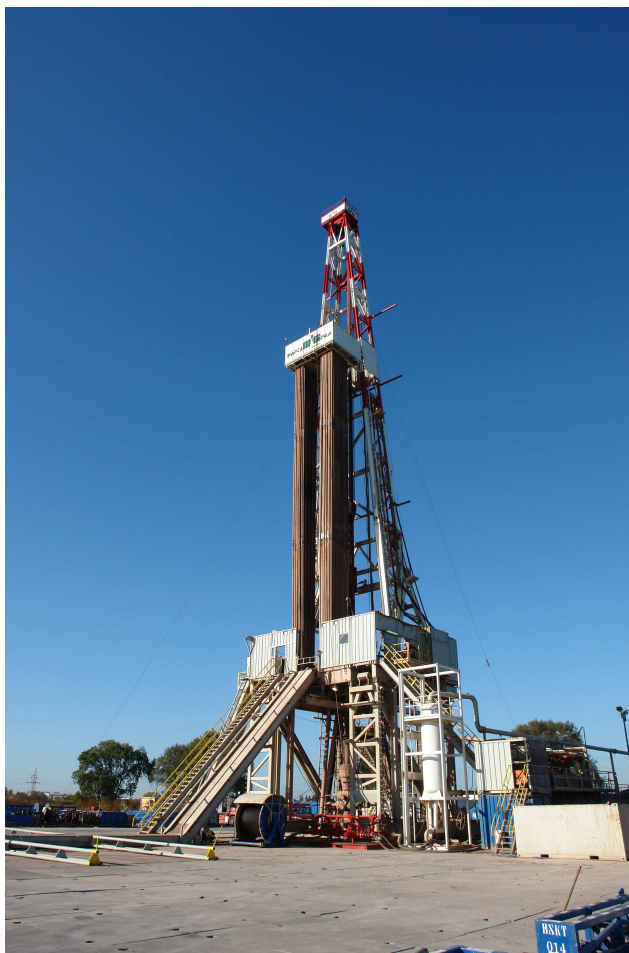
Ryc. 43. Otwór rozpoznawczy złoża gazu ziemnego „Kzesinki-1”.
