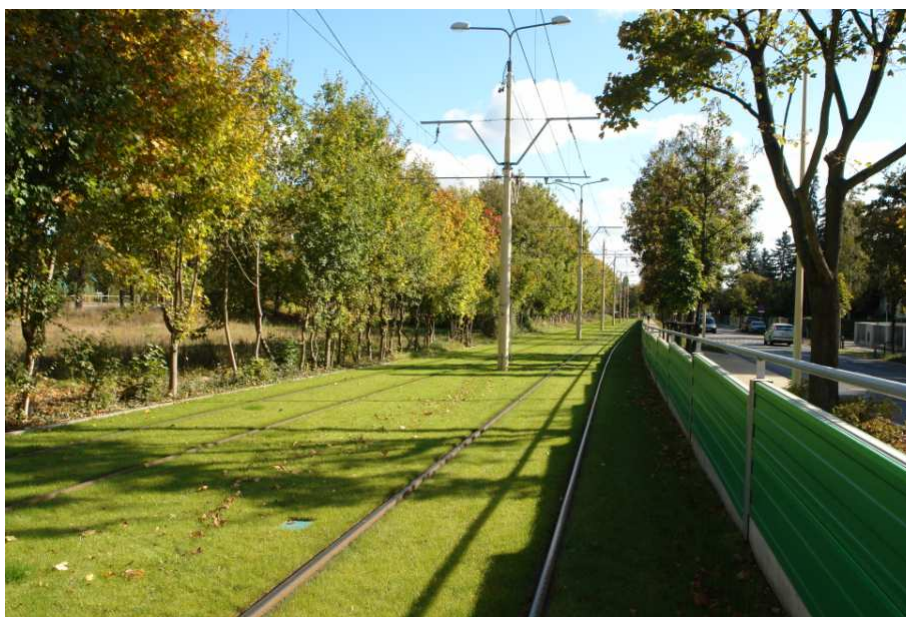
Ryc. 49. Przykład zastosowania zielonej nawierzchni na torowisku tramwajowym (ul. Winogrody w Poznaniu).
