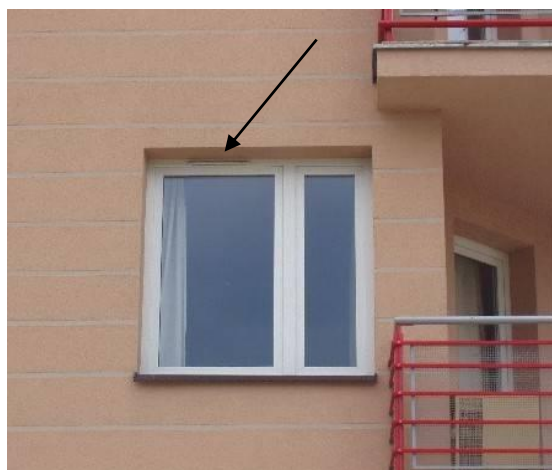
Rysunek 25. Okno dźwiękoszczelne z nawiewnikiem.
