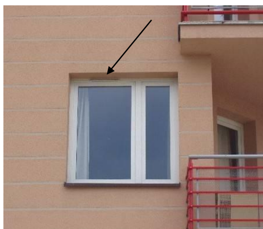
Rysunek 25. Okno dźwiękoszczelne z nawiewnikiem.
