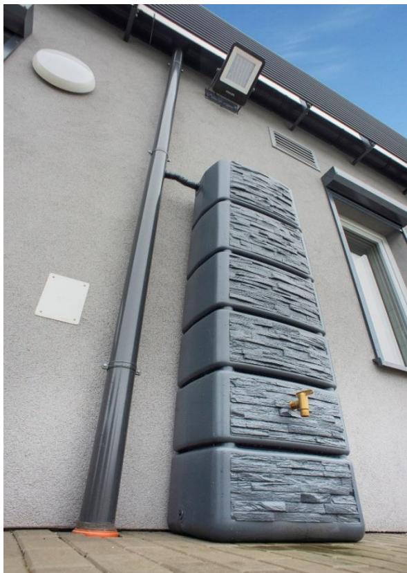
Zbiornik naziemny przy przedszkolu „Justynka” w Stawiszynie
