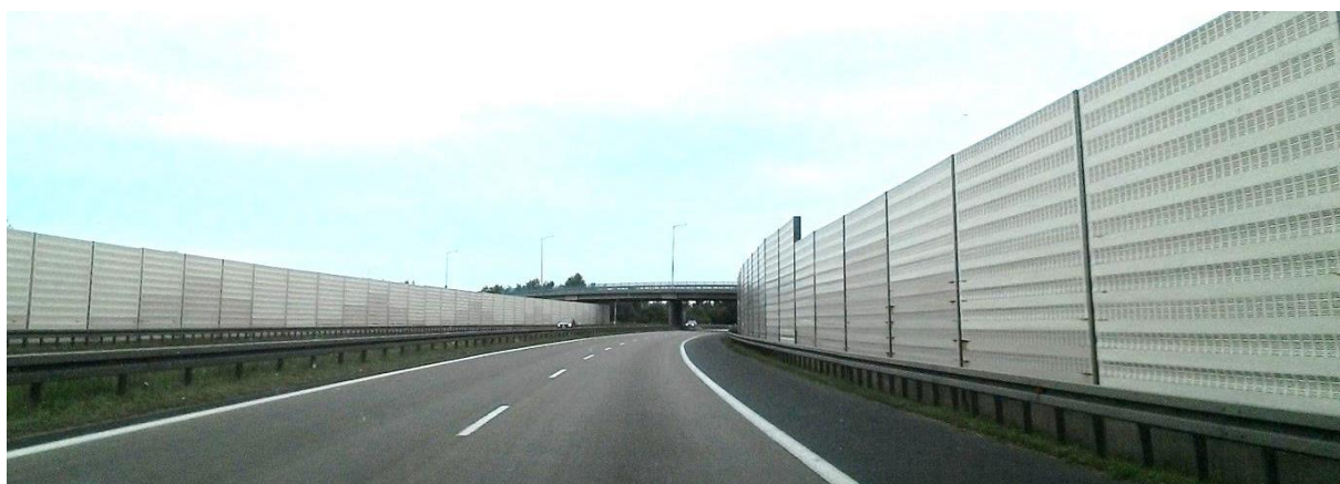
Rys. 21. Ekran przeciwhałasowy pochłaniający (zbudowane z kasetonów)
