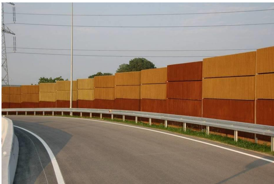
Rys. 17. Ekran przeciwhałasowy (betonowy)
