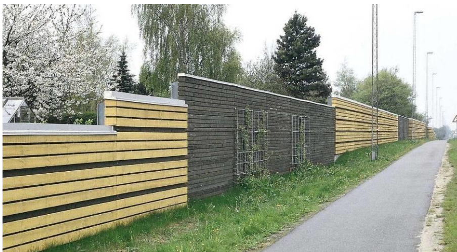
Rys. 18. Ekran przeciwhałasowy (drewniany)
