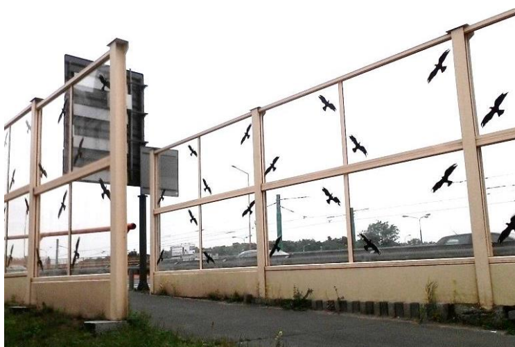
Rys. 19. Przejrzyste ekrany przeciwhałasowe odbijające (na zakładkę)
