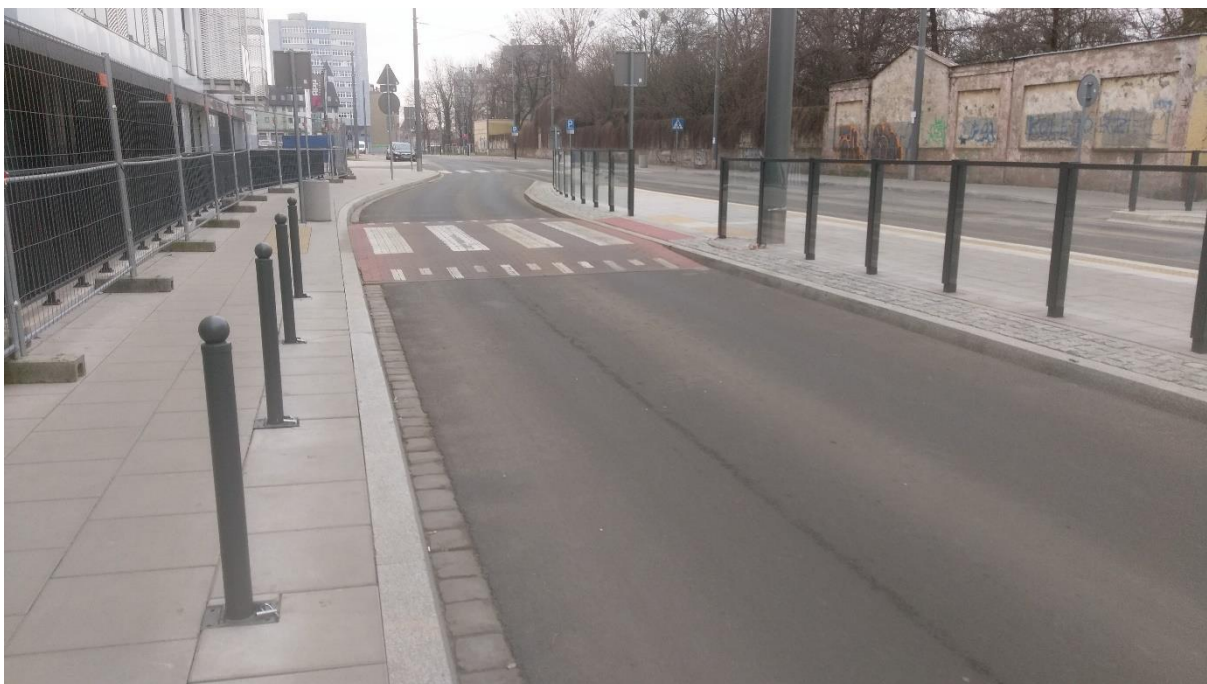
Rys. 9. Przykład wyniesionego przejścia dla pieszych (materiały własne)
