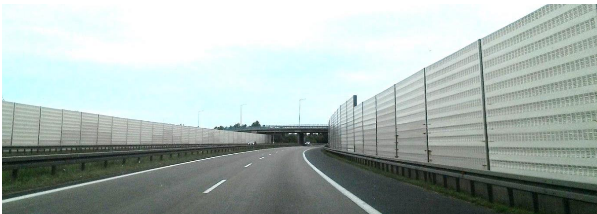
Rys. 18. Ekran przeciwhałasowe pochłaniające (zbudowane z kasetonów)
