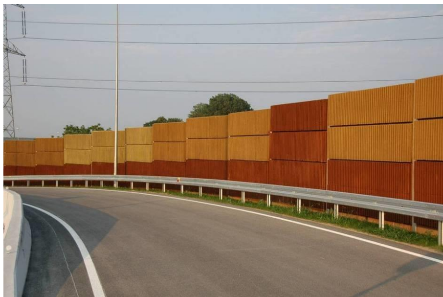
Rys. 14. Ekran przeciwhałasowy (betonowy)
