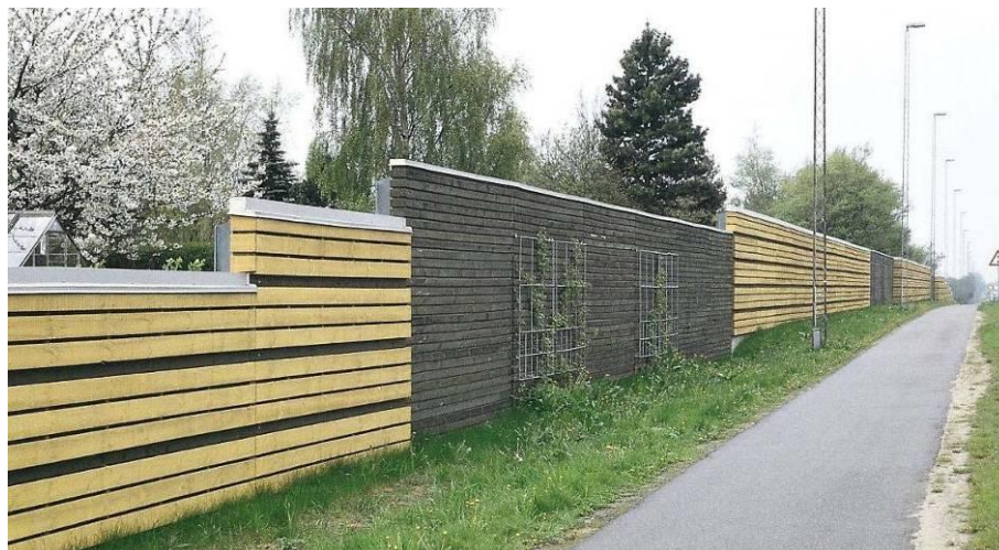
Rys. 15. Ekran przeciwhałasowy (drewniany)
