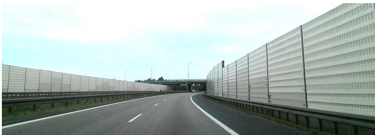
Rys. 21. Ekran przeciwhałasowy pochłaniający (zbudowane z kasetonów)
