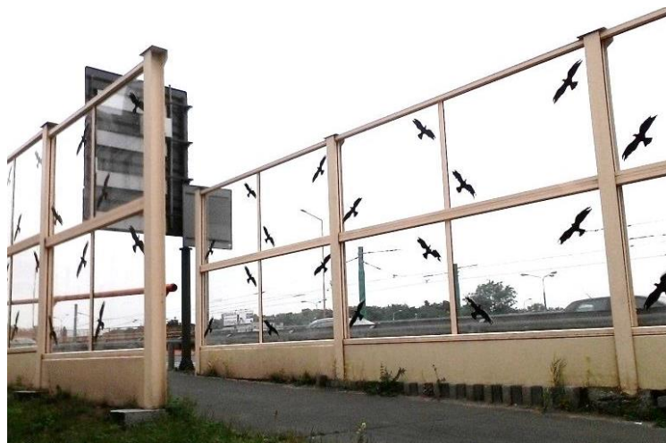
Rys. 19. Przejrzyste ekrany przeciwhałasowe odbijające (na zakładkę)
