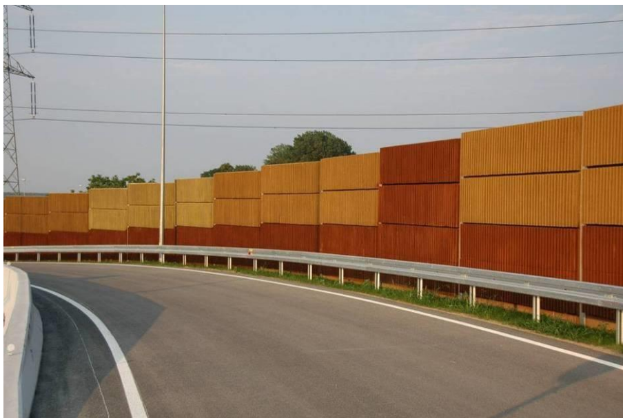
Rys. 13 Ekran przeciwhałasowy (betonowy)
