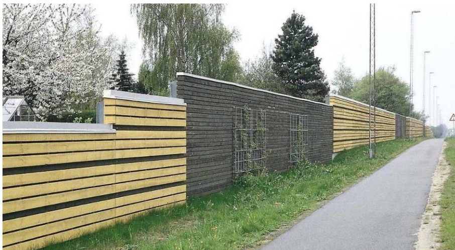
Rys. 15. Ekran przeciwhałasowy (drewniany)
