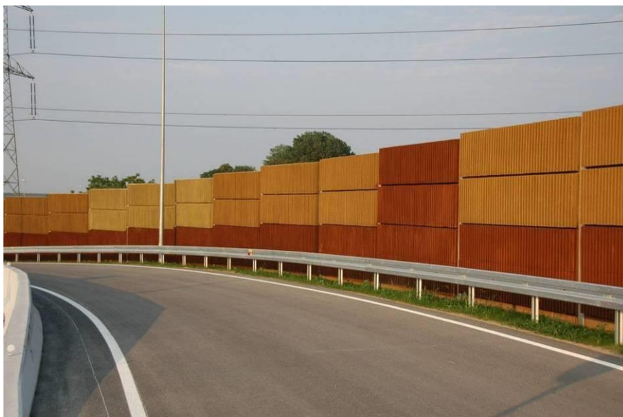
Rys. 14. Ekran przeciwhałasowy (betonowy)
