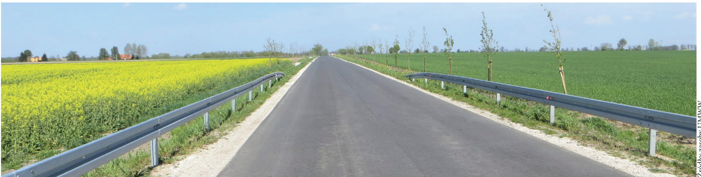
Przebudowana droga powiatowa na odcinku Lekno–Rąbczyn w powiecie wągrowieckim. Inwestycja została dofinansowana ze środków Unii Europejskiej w ramach Programu Rozwoju Obszarów Wiejskich na lata 2014–2020.
