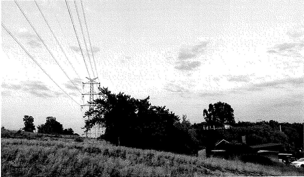
Zdjęcie nr 1. Widok fragment napowietrznej linii elektroenergetycznej 400 kV relacji Jasiniec — Pątnów, przęsło 251 - 252.
