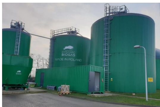
Biogazownia rolnicza w Przybrodzie gm. Rokietnica (Wielkopolska)
