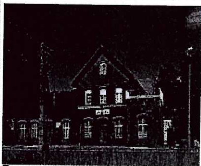
Dworzec kolejowy Jełowa
