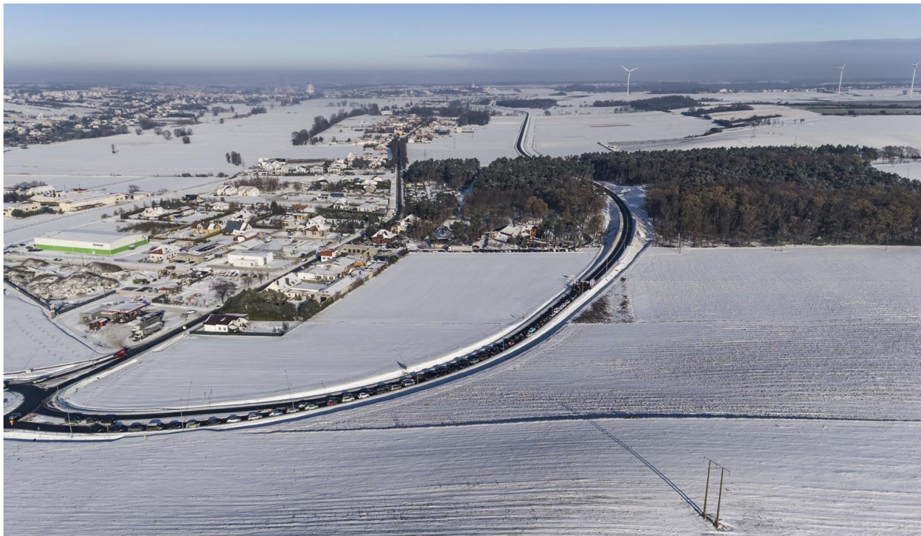
Budowa obwodnicy Gostynia w ciągu drogi woj. nr 434 (łączne nakłady w latach 2018-2023: 139,2 mln zł )
