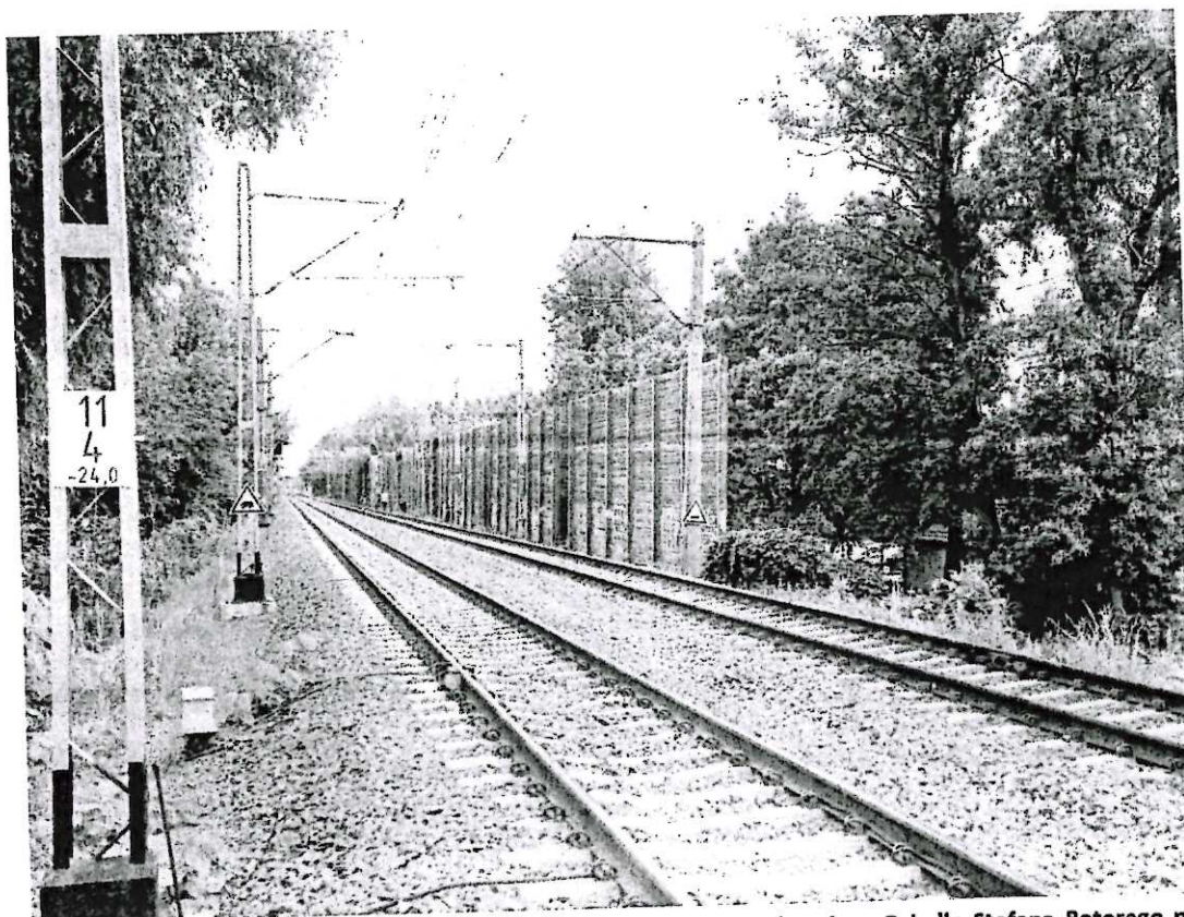
Rysunek 2 Istniejący ekran akustyczny przy linii kolejowej nr 395 chroniący Osiedle Stefana Batorego przed hałasem kolejowym (fot.: Krzysztof Kręciproch)
