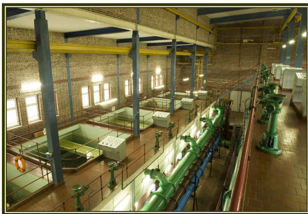
Rys. 5. Wodociąg Ostrów Wlkp. - Stacja Uzdatniania Wody, hala filtrów
