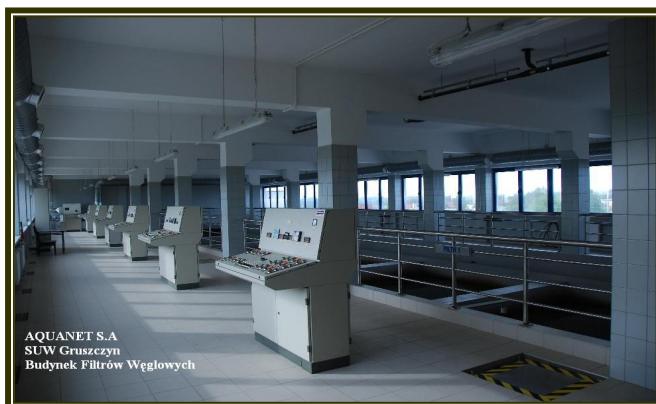
Rys. 4. Stacja Uzdatnia Wody Gruszczyń – Budynek Filtrów Węglowych
