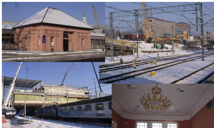
Rys. 4. Przebudowa i rewitalizacja Dworca Głównego PKP w Poznaniu
