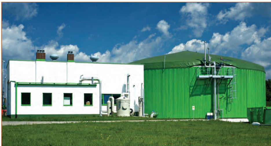
Fot. Biogazownia w Skrzatuszu
