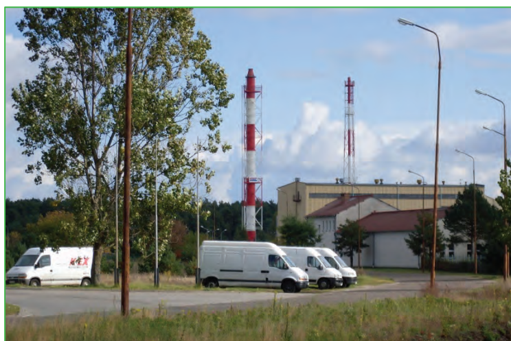
Fot. Miejska Energetyka Ciepła Piła – Kotłownia Rejonowa „Zachód”
