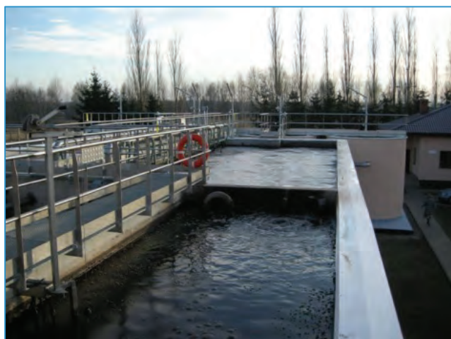
Fot. Zmodernizowana oczyszczalnia ścieków w Orzechowie
