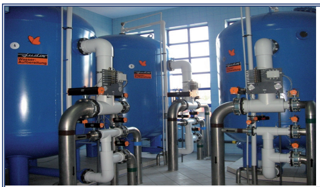
Rys. 7. Wodociąg Publiczny Września – Stacja Uzdatniania Wody
