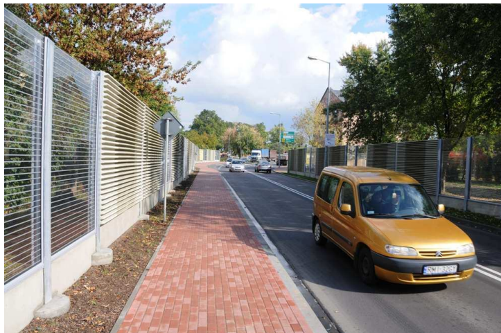
Rysunek 55. Dyfraktor zamontowany na krawędzi górnej ekranu akustycznego (źródło www.techbud.com.pl )
