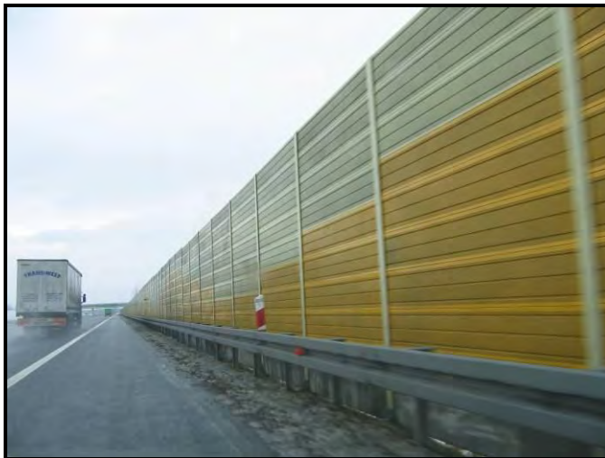
Fot. 4. Przykład typowego zastosowania ekranu akustycznego na autostradzie A2 (Polska)
