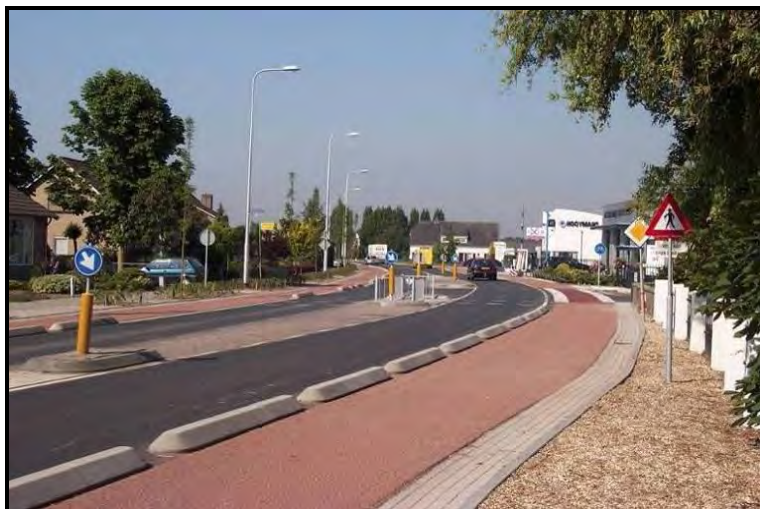
Fot. 2. Przykład strefy ruchu uspokojonego o dopuszczalnej prędkości 50 km/h (Holandia) - droga opowiadająca drodze krajowej w przejściu przez miejscowość
