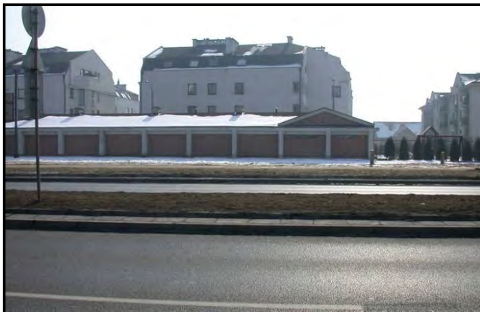
Fot. 5. Ekranowanie obiektów mieszkalnych przez garaże usytuowane bezpośrednio przy ulicy (Polska)
