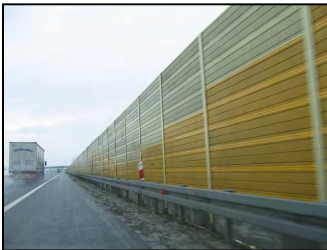
Fot. 4. Przykład typowego zastosowania ekranu akustycznego na autostradzie A2
